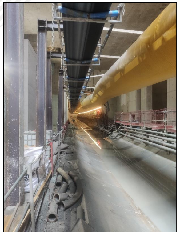
Tunnel du réseau RATP arrivant dans la gare
